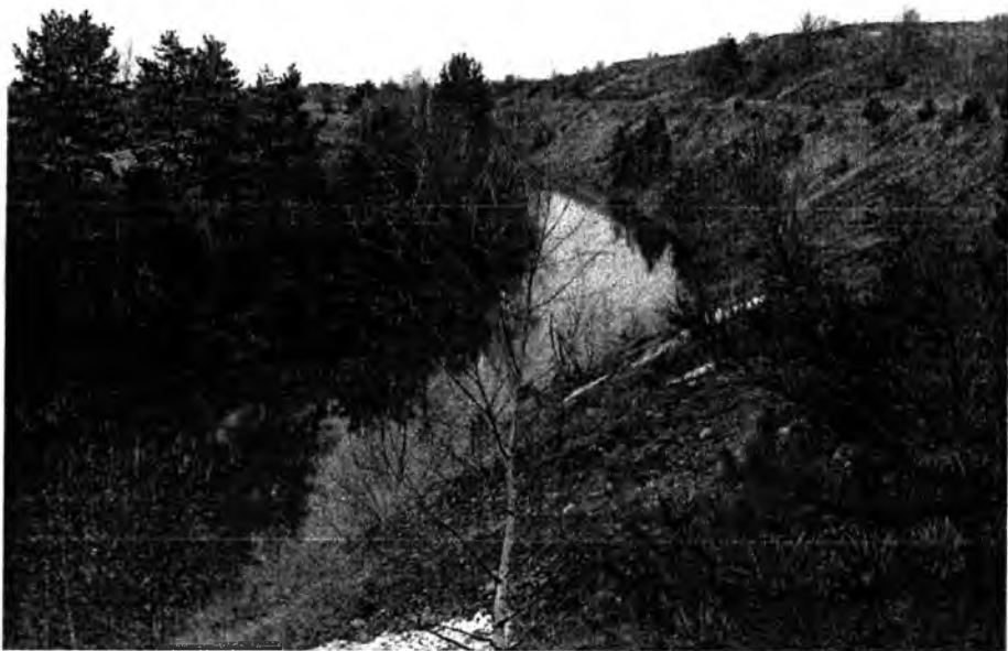
Рис.1 Вигляд дренажної траншеї на даний час
